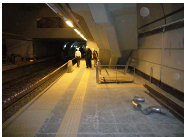
Foto 12 - Anden, corralito y escalera.
