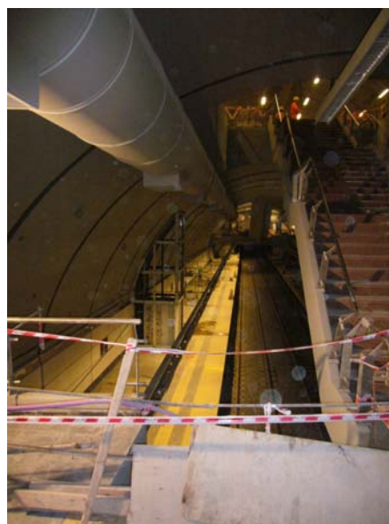
Foto 8 - Apoyo superior en espera de escalera mecánica.
