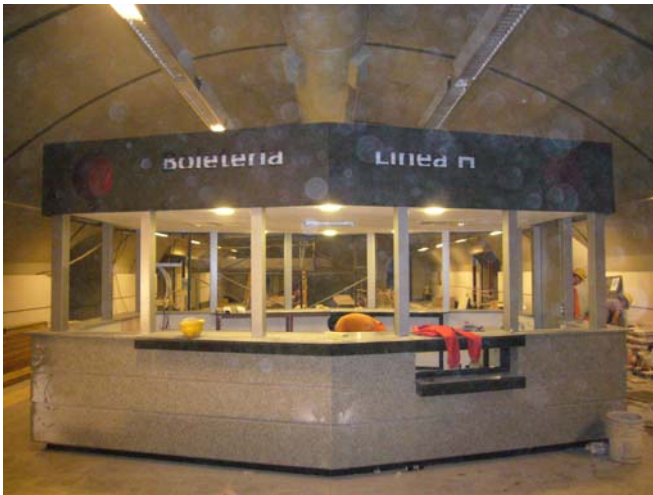
Foto 3 – Boletería con estructura metálica interna.
