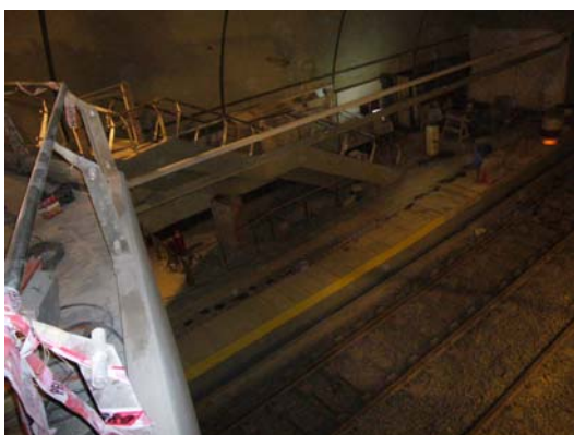
Foto 7 - Terminaciones en ejecución.
