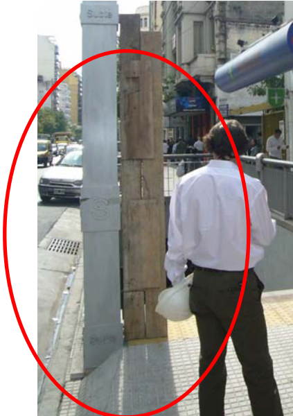
Foto 1- Boca de acceso sobre Av. Pueyrredón.
