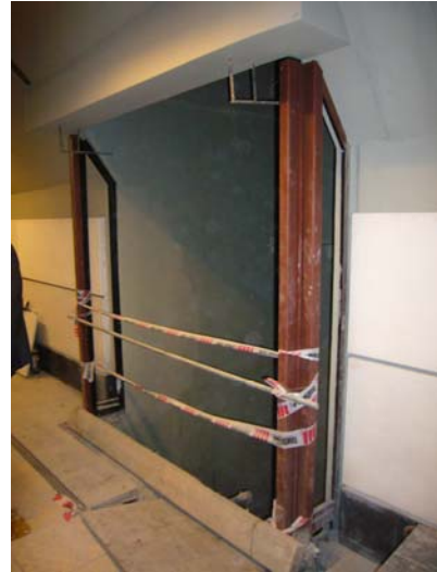
Foto 2 – Acceso a ascensor, interior.
