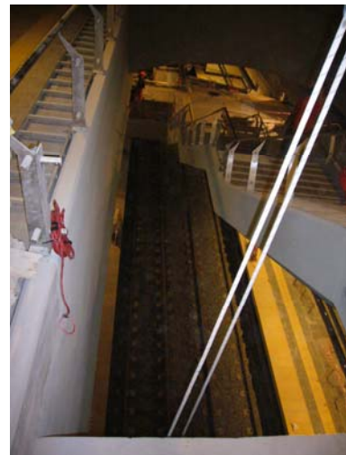
Foto 4 – Vano de escalera mecánica.
