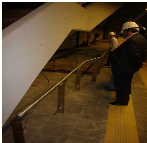
Foto 6 – Ancho de paso (3 baldosas de 40 cm)
